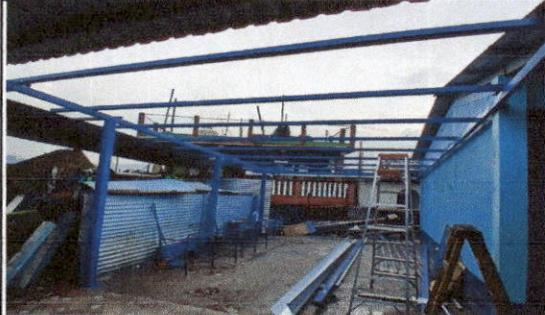
FOTO 7: Sustrucción de estructura de soporte de metal, por metal
